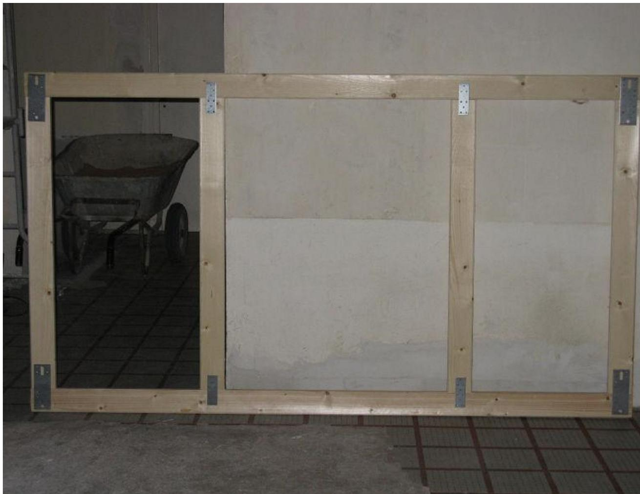
Il a été réalisé à l'aide de BARRE À Z que l'on trouve dans n'importe quel magasin de bricolage. C'est le morceau de bois qui sert à assembler des lattes de volets, celle qui forme le dessin en "Z", d'où son nom...
